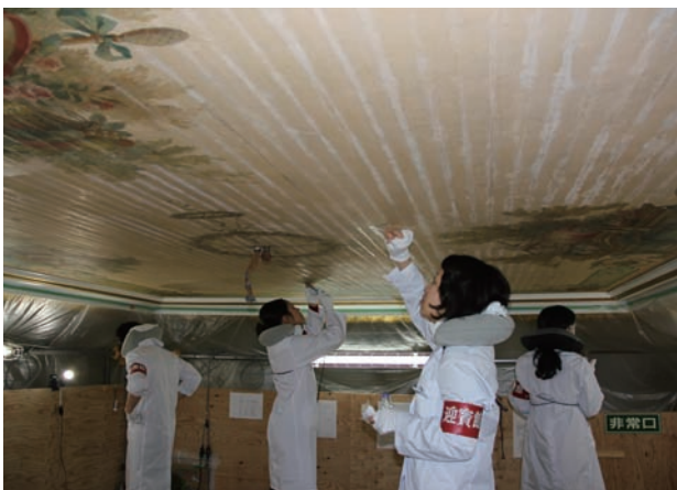
図10 浮き上がり接着：膠分洗浄中
