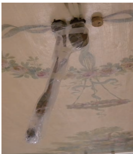
図8 シャンデリア電源コードを養生シートで養生し、取付口をコルクでふさぐ
