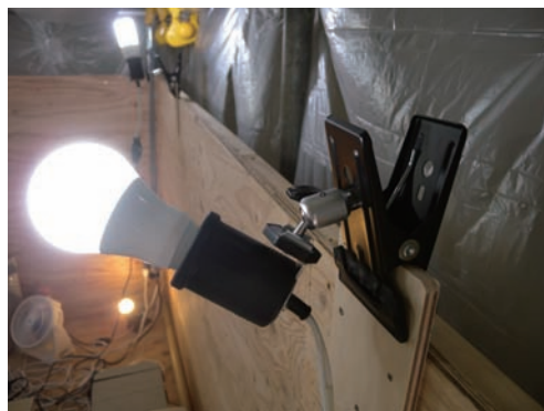
図16 ランプホルダーで足場壁に取り付け
