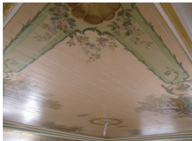
図3 塗布後の状態
