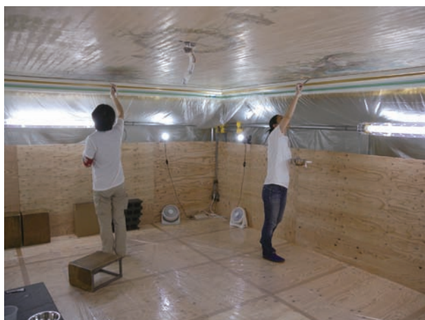
図2 刷毛塗り：周縁は飛沫飛散防止のため幅の狭い筆で塗布
