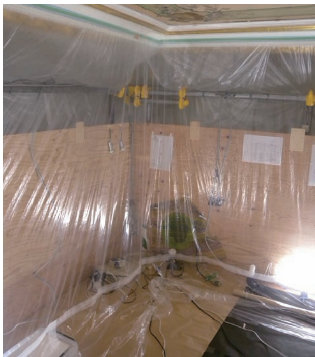
図5 養生シートで周囲を囲む
