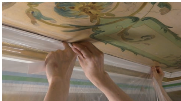
図6・7 周り縁隙間に厚紙を差し込み養生シートでを固定
