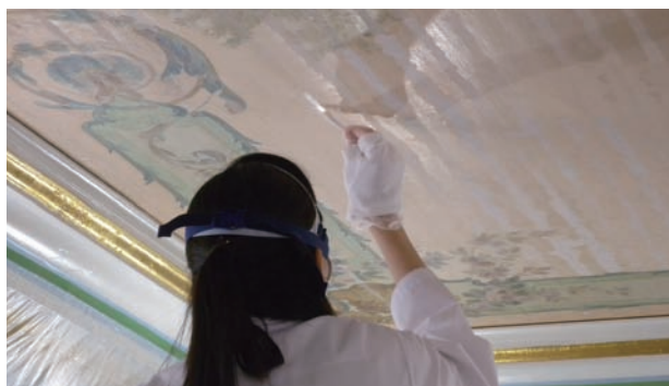
図5 充填整形作業：余分な充填剤を洗浄
