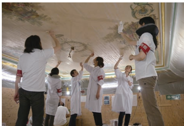
図3 充填整形作業：木拵間の隙間の損傷部に充填剤を充填
