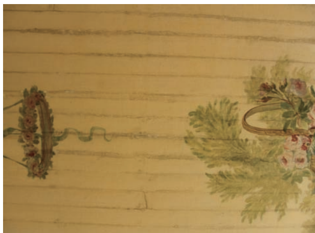
図7 筋状の損傷（修復前）
