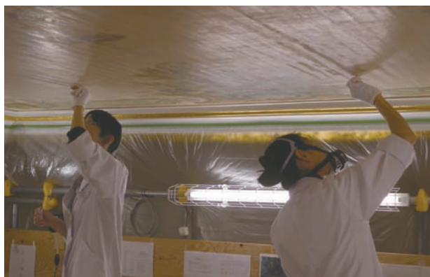
図4 充填整形作業：余分な充填剤を洗浄
