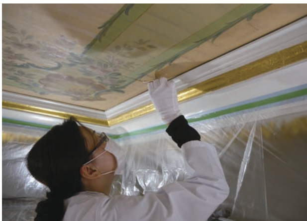
図2 汚れ洗浄作業
